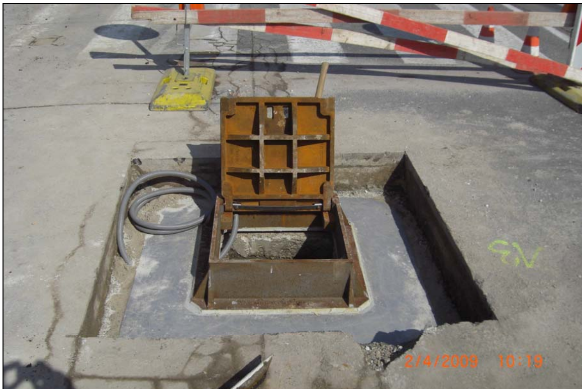
Abb. 3: Foto des ANA-Systems, das gerade eingebaut wird (zu erkennen ist der Schachtdeckel, die Klebschicht und die darunter liegende graue Platte, das Dilatationselement).
