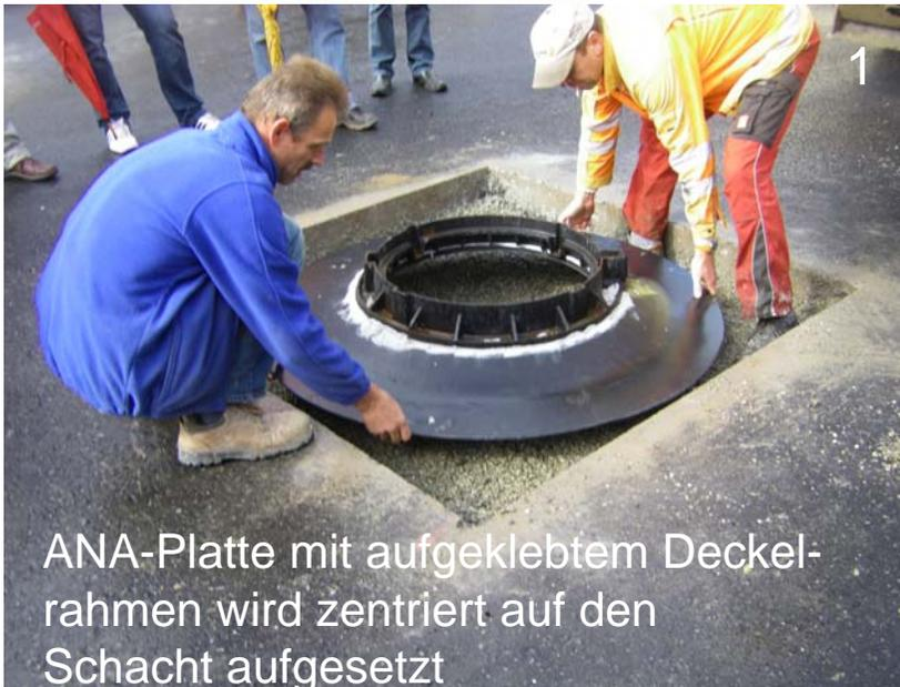
ANA-Platte mit aufgeklebtem Deckel-
